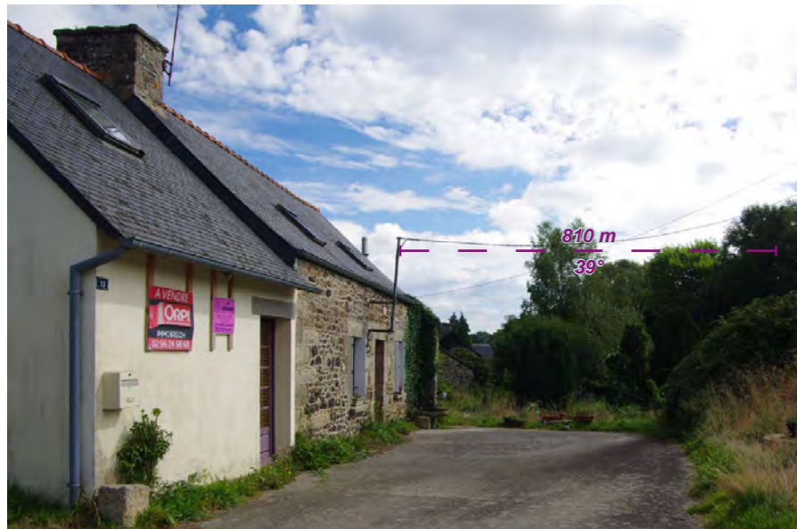
Photo 25. Autre point de vue à Moustermeur qui illustre la majorité des vues du hameau : la façade de l'habitation est orientée vers le sud plutôt que vers le projet; la densité végétale filtre les vues, mais peut, à l'occasion de fenêtres visuelles étroites, permettre quelques perceptions tronquées du secteur du projet.
